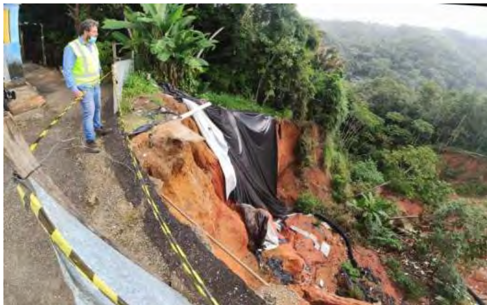
Figura 0.7 Vista superior da parte lateral direita do talude tirada em 20.07.22, observar a queda do tapume devido a novos escorregamentos ocorridos devido às chuvas recentes e consequente estreitamento do acesso.
