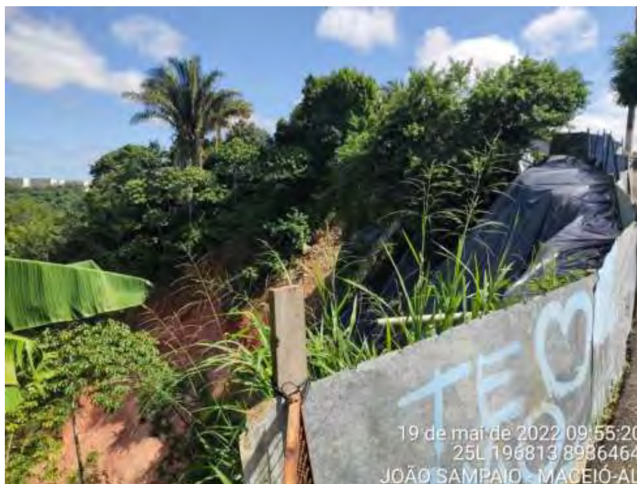
Figura 0.7 Vista superior da parte lateral direita do talude tirada em 20.07.22, observar a queda do tapume devido a novos escorregamentos ocorridos devido às chuvas recentes e consequente estreitamento do acesso.
