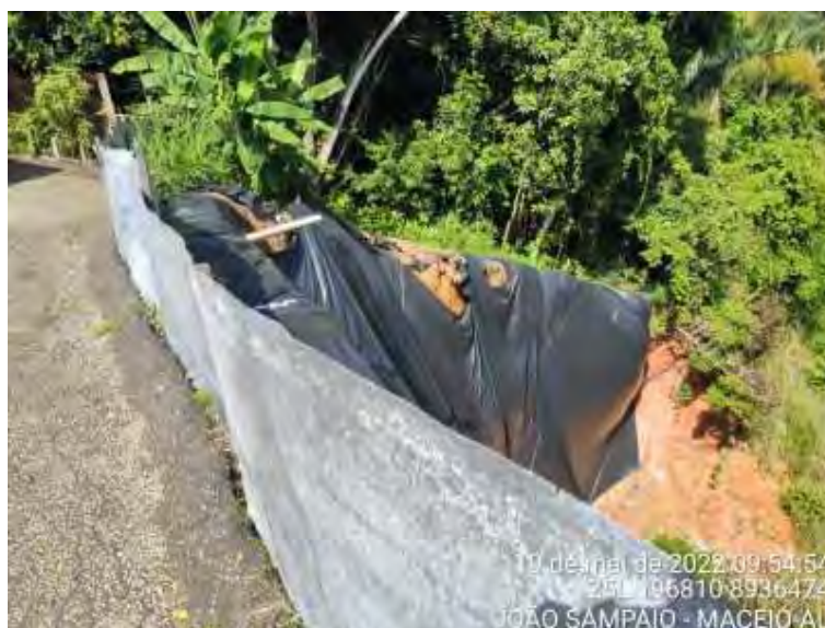
Figura 0.5 Vista da parte superior esquerda do talude após novos escorregamentos, registro de 20.07.22.
