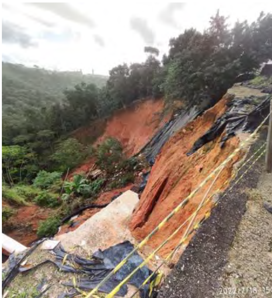
Figura 0.5 Vista da parte superior esquerda do talude após novos escorregamentos, registro de 20.07.22.
