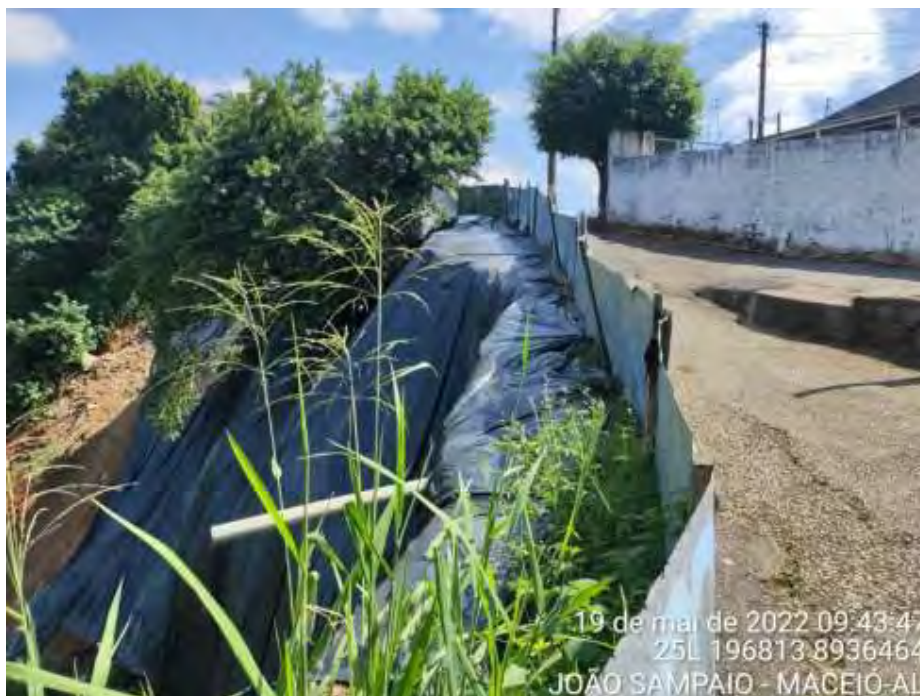
Figura 0.9 .-Vista lateral do ponto que sofreu escorregamento, observa-se o passeio sem meio fio próximo a crista do talude.
